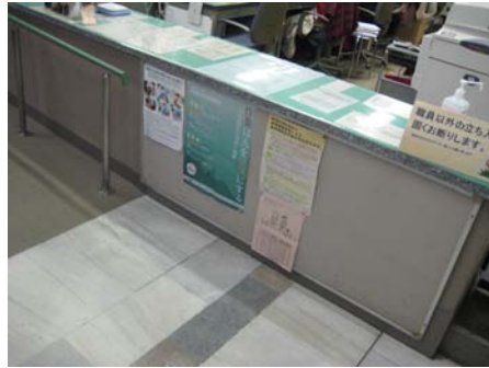
④ 窓口カウンター ・カウンターが高く、車いす使用者のひざが入らない形状である。
